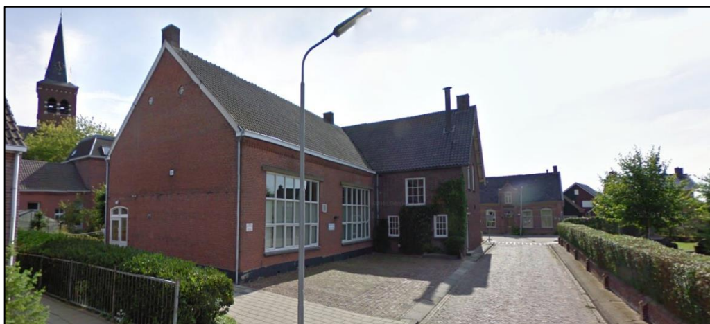
Aanzicht vanuit de Vierlinghstraat naar het plangebied. De achterzijde van de bebouwing in het plangebied is hier zichtbaar. Het oranjekeurige gedeelte van het gebouw wordt gesloopt ten behoeve van de ontwikkeling van de vrijstaande woning. Bron: Google Maps 2010
