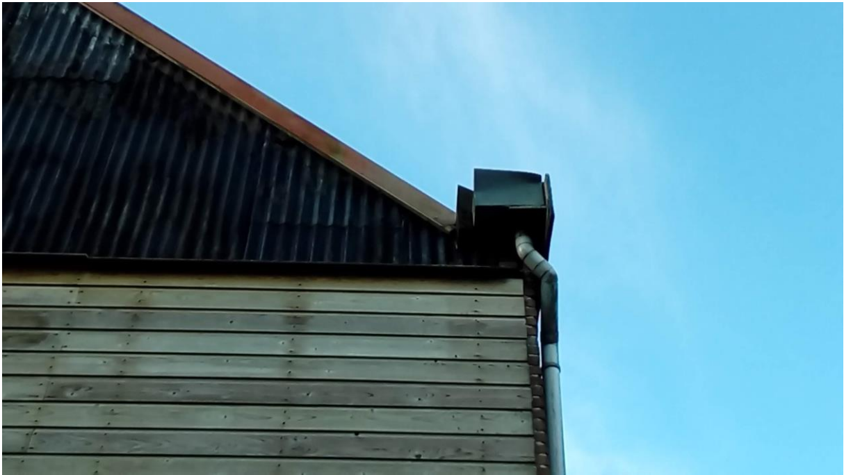
Dakrand van het garagedeel van de woning:
