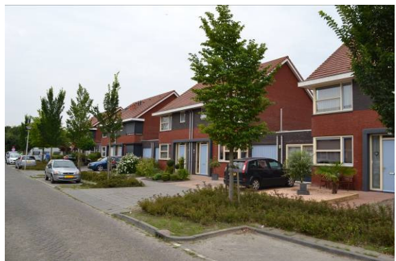
Nieuwbouw aan de Burgemeester Meester H. Popstraat
