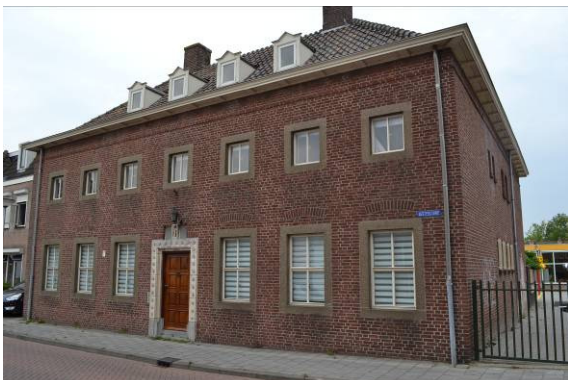
Monumentaal pand aan Westerstraat
