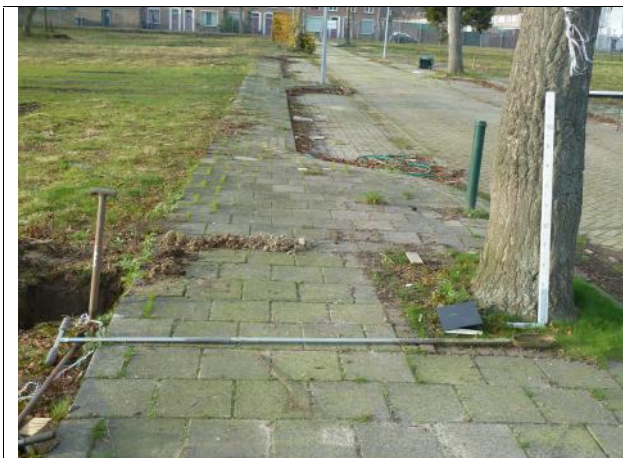
Profielsleuf langs voetpad op ca. 2,10 uit hart boom
