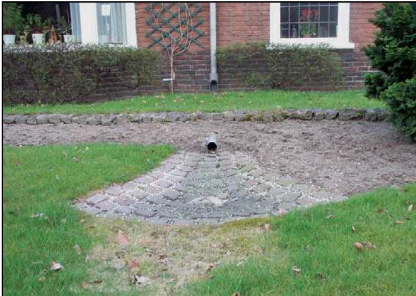
Figuur 16: Voorbeeld van een infiltratieveld
