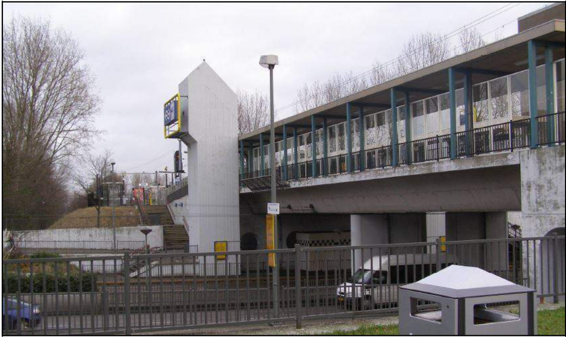
Afbeelding 3: Zicht op station Schiedam Nieuwland.
