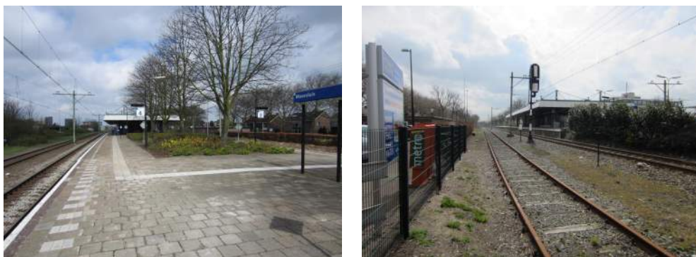
Figuur 4.7 Beeld van de Referentiesituatie ter plaatse van station Maassluis Centrum
