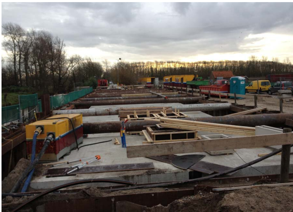
Figuur 3.6 Aanleg bergbezinkbassin aan de zuidkant van het plangebied, oktober 2012. [foto: Tauw]
