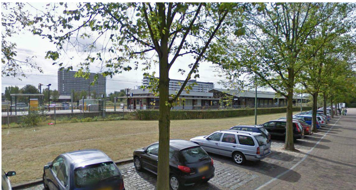
Figuur 4.9 Station Vlaardingen Centrum, gezien vanaf de centrumzijde [bron: Google Street View].
