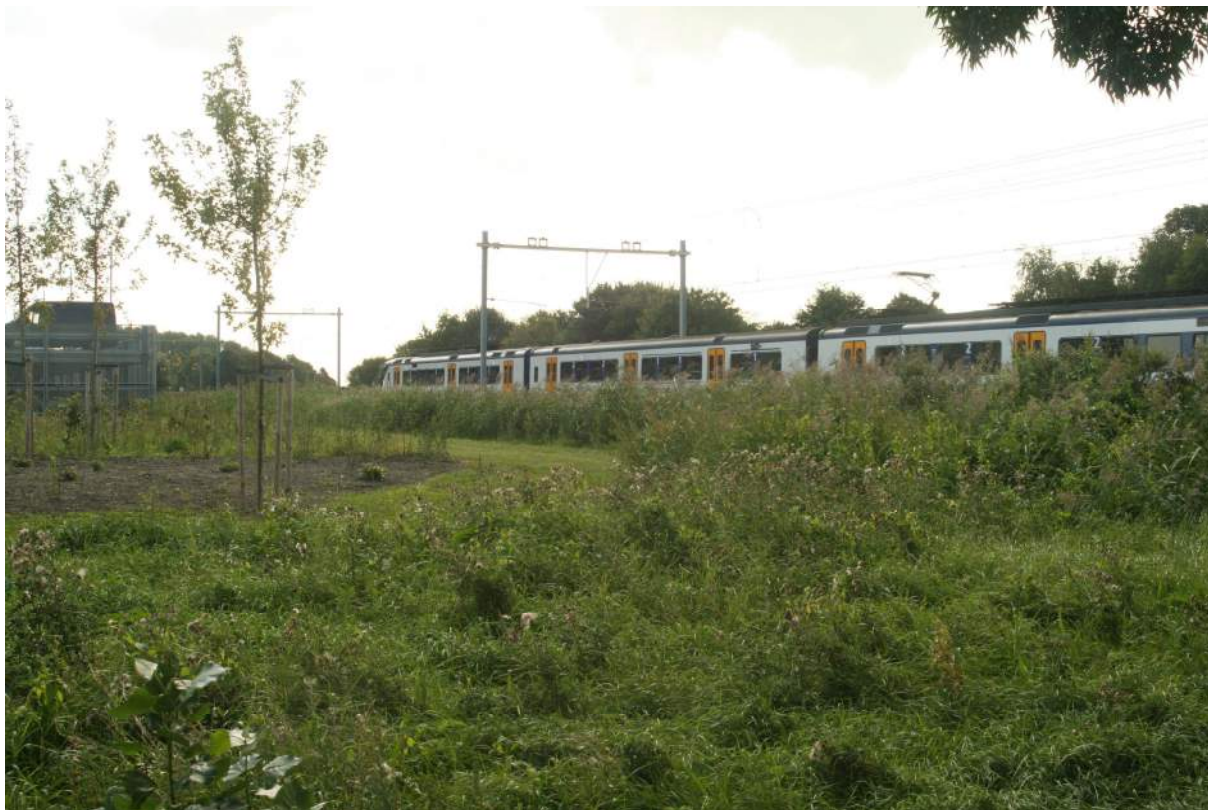
Figuur 4.21 De locatie van het geplande station Maassluis Steendijkpolder, links op de foto is de parkeergarage van de torenflats aan de Merellaan.
