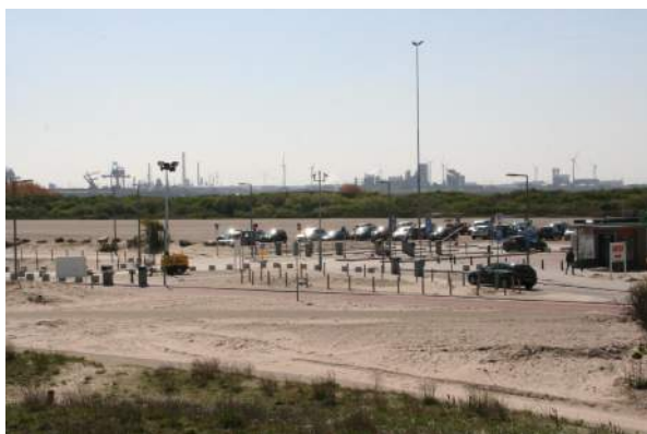
Figuur 4.31 De entree naar het grote parkeerterrein aan de Badweg.
