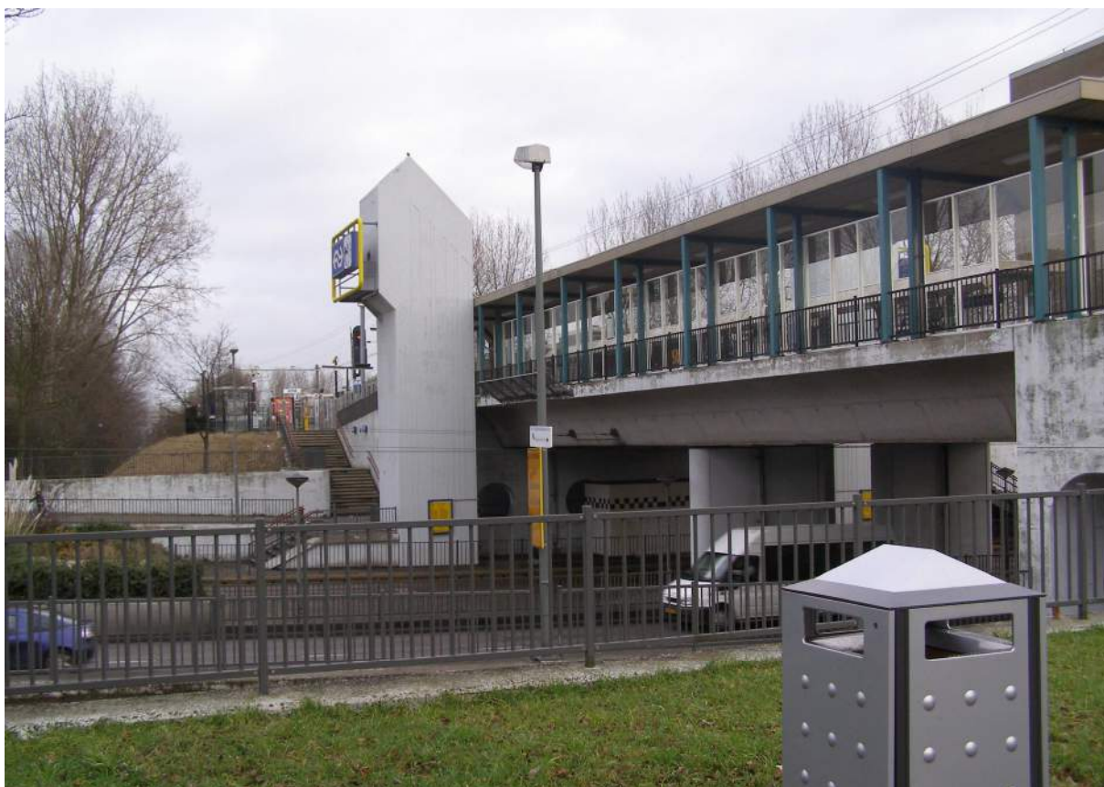
Figuur 4.3 Station Schiedam Nieuwland, gedeeltelijk op een viaduct over de Nieuwe Damlaan.
