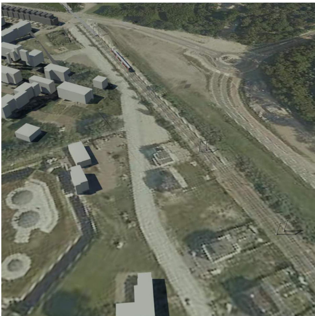
Figuur 6.2 Impressie van de gelijkvloerse kruising van het spoor met de Strandweg.
