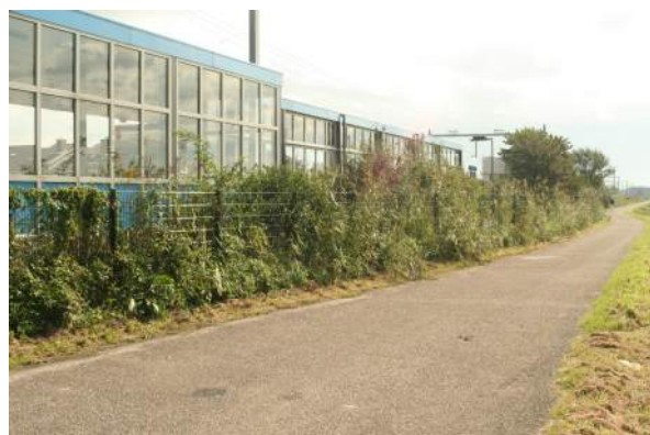
Figuur 4.20 Station Maassluis West, gezien vanaf de zuidzijde.
