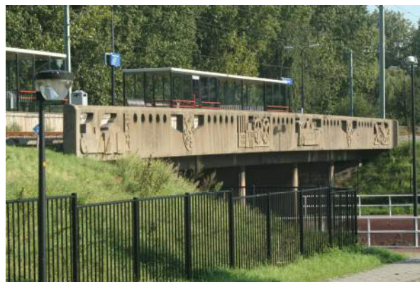
Figuur 4.8 Station Vlaardingen Oost, het kunstwerk aan de zuidoostzijde van het viaduct.
