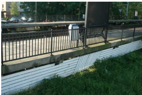
Figuur 4.4 Station Schiedam Nieuwland, schotten onder zwevend perron.
