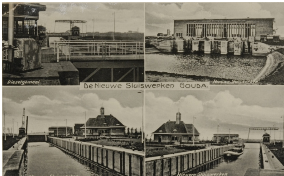
Figuur 2: Vier verschillende opnamen uit 1935 van de nieuwe sluiswerken in de Gouwe, bestaande uit de Julianasluis en het dieselgemaal mr. P.A. Pijnacker Hordijk.
