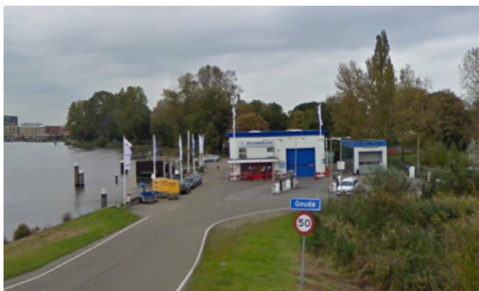
Figuur 5: Het tankstation (bron: google streetview)
