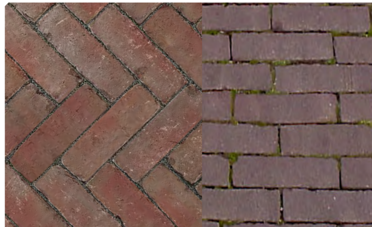
Rijbanen: elementenverh. dikformaat, roodbruine natuurlijke uitstraling, keperverband, rabbatstroken in de Linten: elementenverh. dikformaat, paarsbruine natuurlijke uitstraling, halfsteensverband
