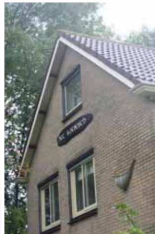
Nok + dak woonhuis
