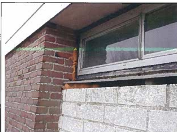
Foto 1: Het AFC gebouw heeft openingen die vleermuizen toegang kunnen geven tot de spouw
