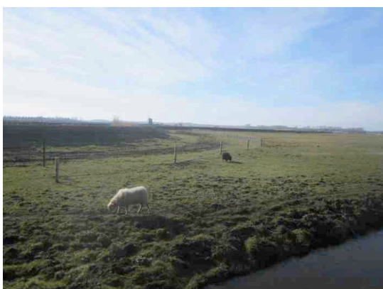
De binnenzijde van de dijk. Ter hoogte van het toekomstige fietspad lopen zware tractorsporen
