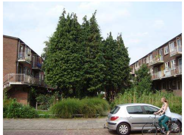
Foto 6. Lauwerecht-Oost: achtertuinten Nolenlaan/Samuel Mullerstraat.
