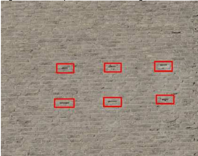
Fig. voorbeeld open boren stootvoegen
