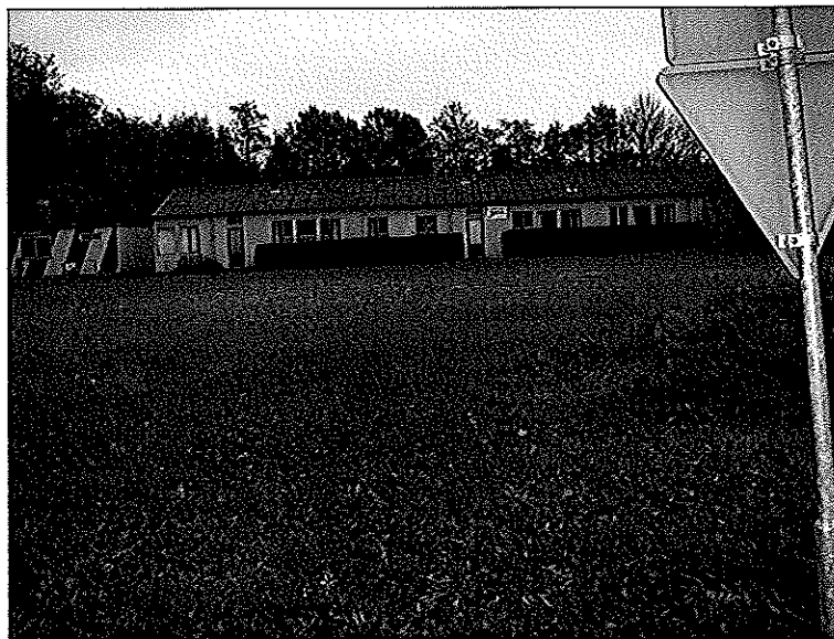
Foto b3.2 Barak zuidwestzijde locatie
