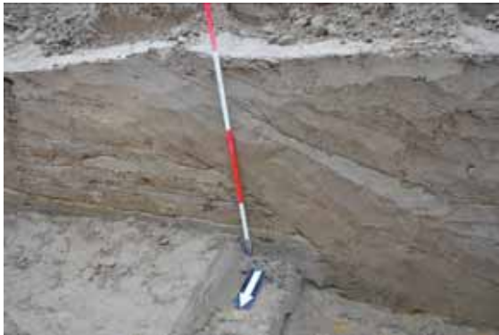
55. Insteek van de vestingmuur. Deze is later ingegraven door de horizontale zandlagen van het aardwerk van de lunet.
