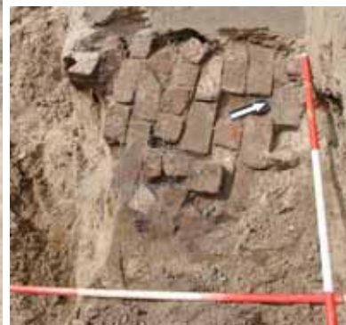
59-60. Met bakstenen bekleed contrescarp van de couvre-face, gezien vanuit de gedempte kapitale gracht. Rechts een detail van deze bekleding.
