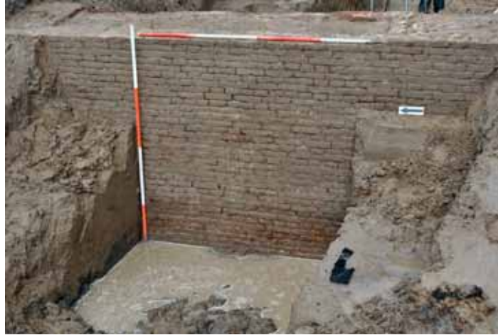
50. Aanzicht van de vestingmuur vanaf de veldzijde.
