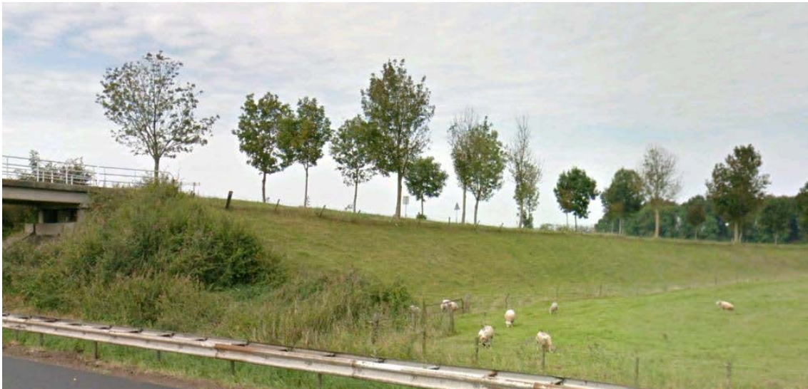
Figuur 4.1 Slecht ontwikkelde essen op het bestaande talud Voskuilerdijk
