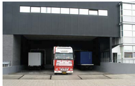
Loading docks onderdeel architectuur
