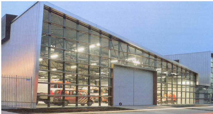
Lichte en open constructies naar de openbare ruimte
