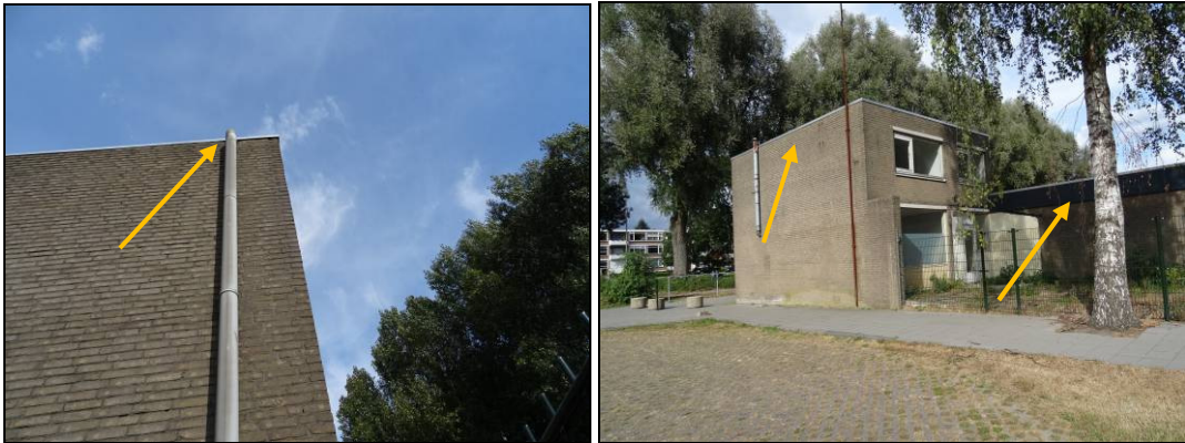
Figuur 8. Mogelijke toegangen tot verblijfplaatsen van vleermuizen.
